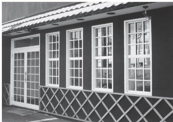
写真4. 大型開口部（テラス窓）を小型化・防寒改修の事例2
