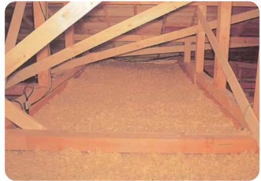
天井フローイング工事
